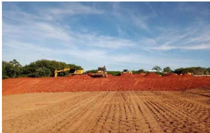
EXECUÇÃO DAS CAMADAS DE ATERRO
