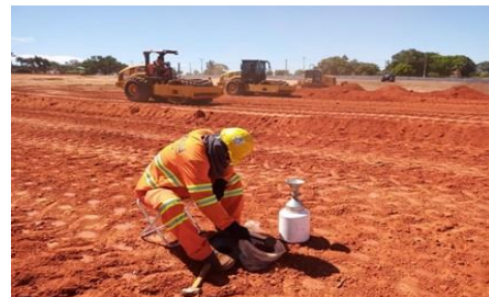
ENSAIO DO GRAU DE COMPACTAÇÃO
