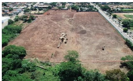
VISTA ÁEREA DO TERRENO LIMPO
