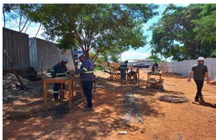
EXECUÇÃO DAS FERRAGENS DE ARMAÇÃO
