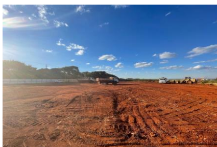
LIMPEZA DO TERRENO
