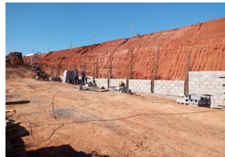
EXECUÇÃO DA ALVENARIA
