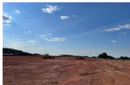
LIMPEZA DO TERRENO
