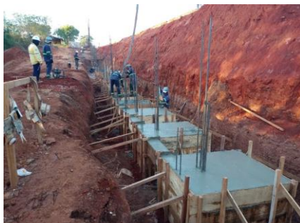
CONCRETAGEM DOS BLOCOS
