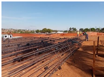
EXECUÇÃO DAS ARMAÇÃO DAS ESTACAS
