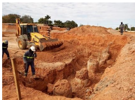
ARRASAMENTO DAS ESTACAS DA DOCA DA CÂMARA FRIA
