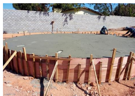
BASE DO RESERVATÓRIO METÁLICO CONCRETADA
