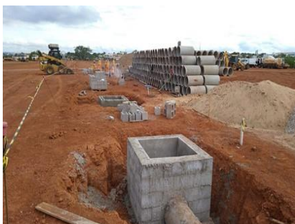
CONCRETAGEM DOS FUNDOS DAS CAIXAS DE DRENAGEM
