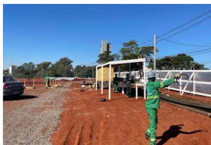
EXECUÇÃO DE ABRIGO PARA ARMAÇÃO
