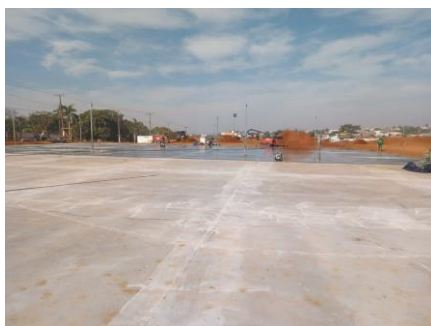
EXECUÇÃO DO PISOS E POSTES DE ILUMINAÇÃO
