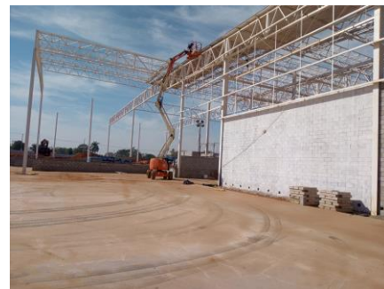
EXECUÇÃO DAS ESTRUTURAS METÁLICAS
