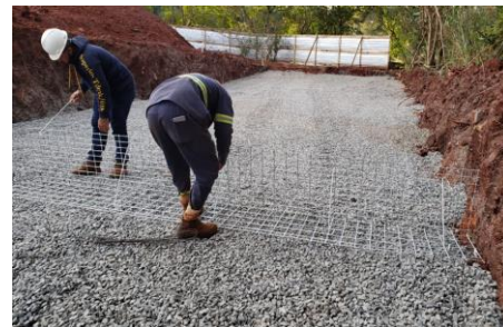
EXECUÇÃO MURO DE ARRIMO
