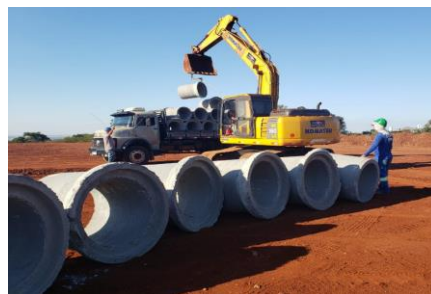
RECEBIMENTO TUBOS DE DRENAGEM PLUVIAL
