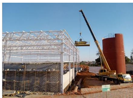
EXECUÇÃO DAS ESTRUTURAS METÁLICAS
