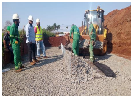
EXECUÇÃO DE MURO DE ARRIMO NO MÉTODO STRATASLOPE
