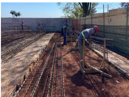
ARMAÇÃO DAS ESTACAS
