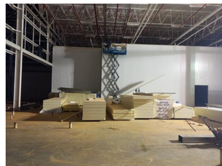
EXECUÇÃO PAINÉIS DA CÂMARA FRIA
