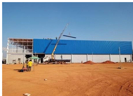
EXECUÇÃO DAS TELHAS DE FECHAMENTO
