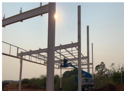
EXECUÇÃO ESTRUTURA METÁLICA
