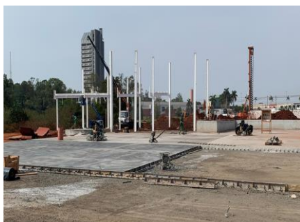
EXECUÇÃO PISO DE CONCRETO
