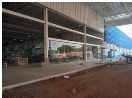
EXECUÇÃO DO VIDRO FRENTE DE LOJA
