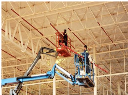
EXECUÇÃO INSTALAÇÃO HIDRÁULICA
