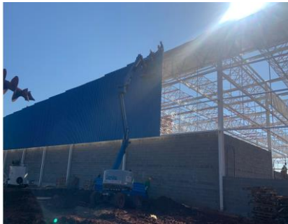
EXECUÇÃO TELHAS METÁLICAS
