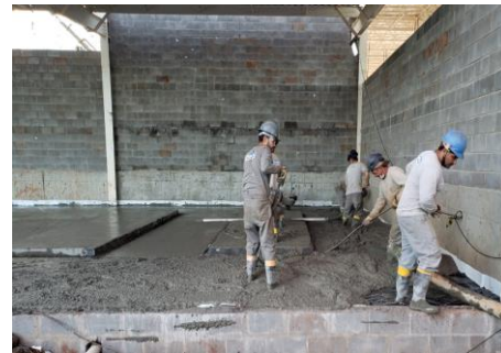
EXECUÇÃO PISO DE CONCRETO
