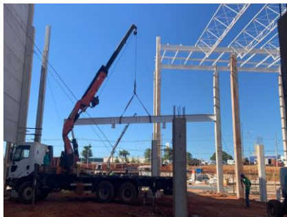
MONTAGEM DAS JOISTS
