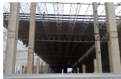
EXECUÇÃO DAS TELHAS DE COBERTURA
