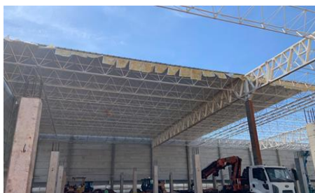
MONTAGEM DAS TELHAS DE COBERTURA
