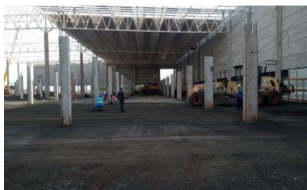
PREPARO DA BASE DO PISO
