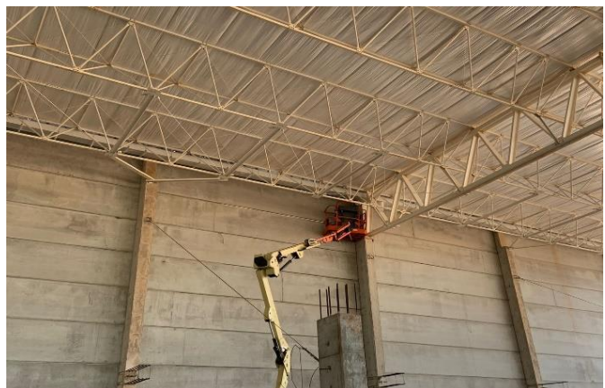
TRAVAMENTO DA COBERTURA METÁLICA
