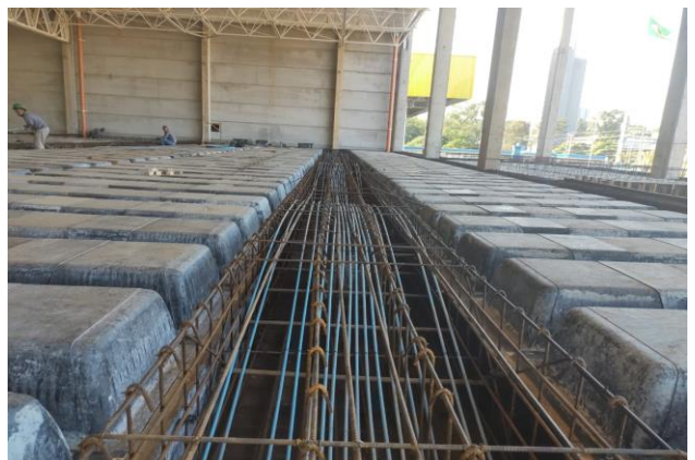
EXECUÇÃO ARMADURA E PROTEÇÃO DAS VIGAS
