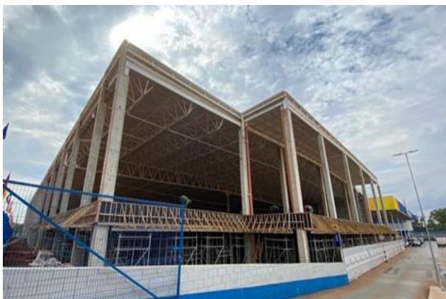
MONTAGEM DAS FORMAS
