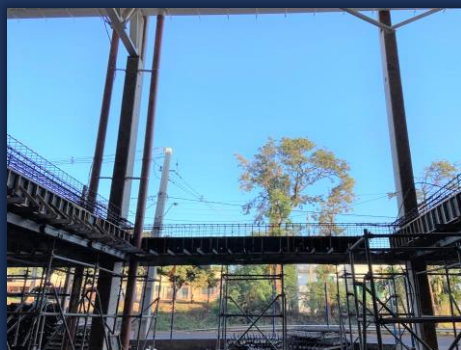
Travamento das vigas
