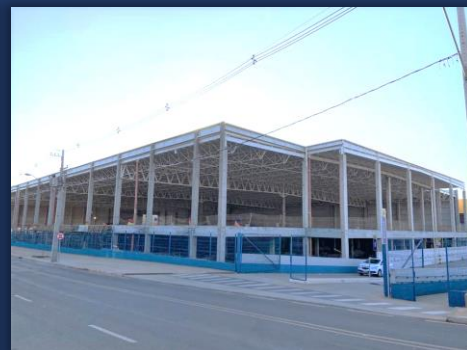
Remoção do tapume na fachada lateral
