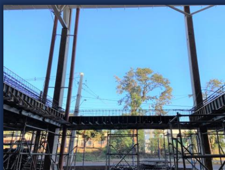
Travamento das vigas
