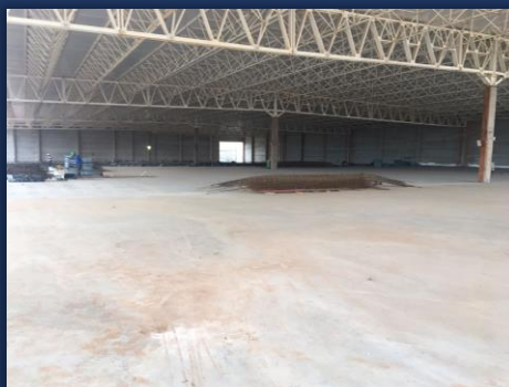
Segundo pano de laje
