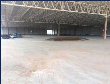
Segundo pano de laje
