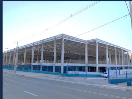
Remoção do tapume na fachada lateral
