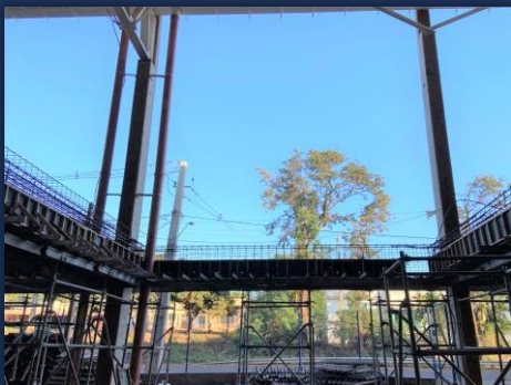
Travamento das vigas
