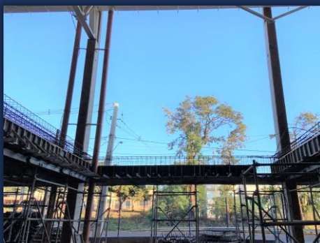
Travamento das vigas
