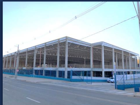
Remoção do tapume na fachada lateral
