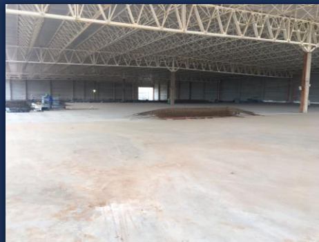
Segundo pano de laje
