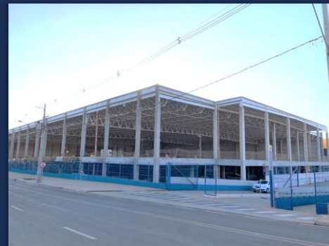
Remoção do tapume na fachada lateral
