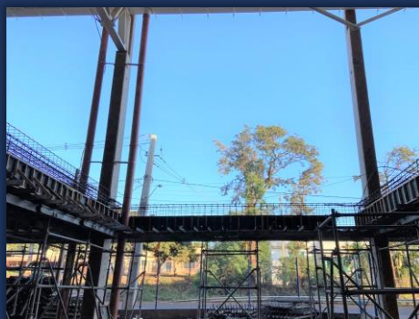
Travamento das vigas
