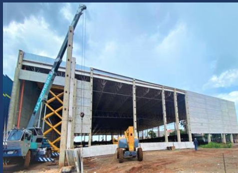
Retirada de placas pré moldadas
