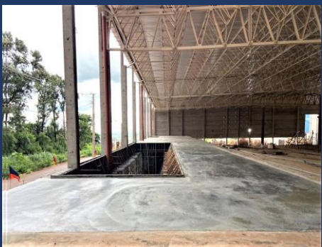
Concretagem complemento de laje
