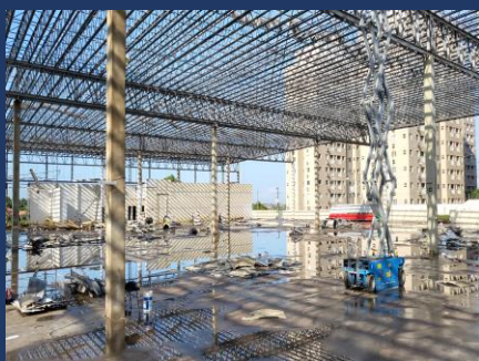
Desmontagem da cobertura
