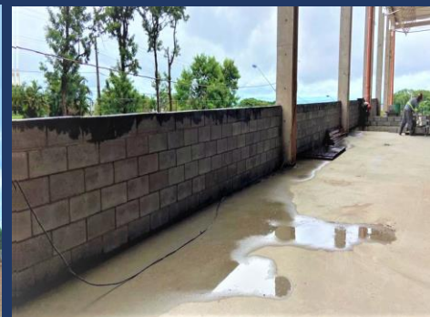
Início alvenaria perimetral
