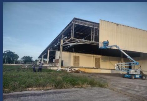
Fechamento da estrutura metálica lateral
