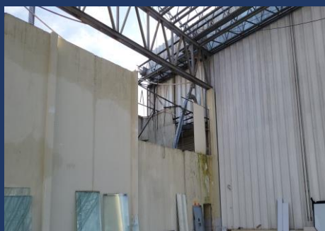
Fechamento da estrutura metálica lateral
