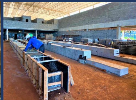
Concretagem dos Pilares
