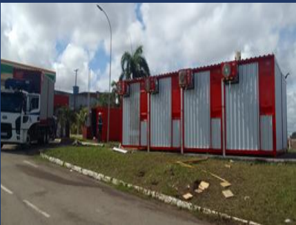
Montagem do canteiro de obras
