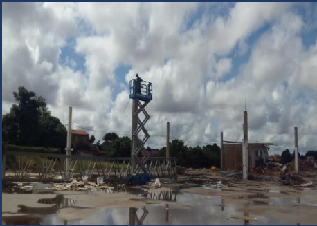
Desmontagem da Estrutura
