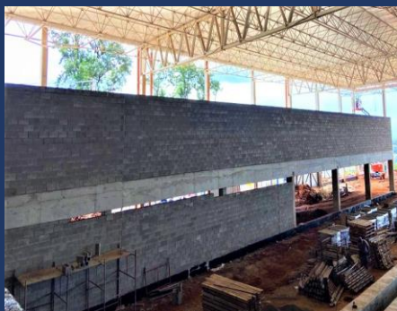
Alvenaria – Fechamento da Loja
