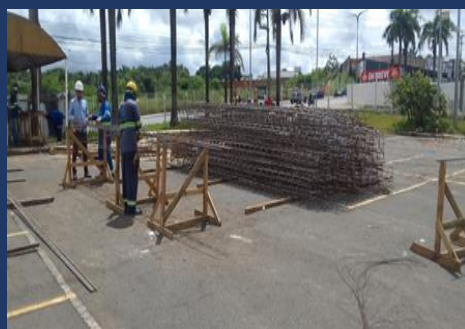
Armação das Estacas
