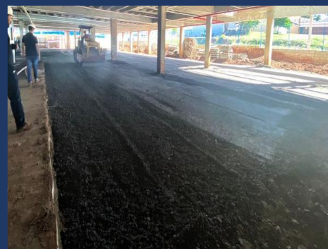
Preparo Base Piso do Estacionamento
