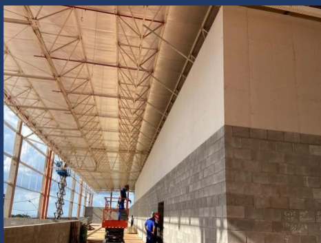
Fechamento em Drywall – Primeiro Pavimento
