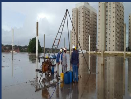
Execução de Sondagem
