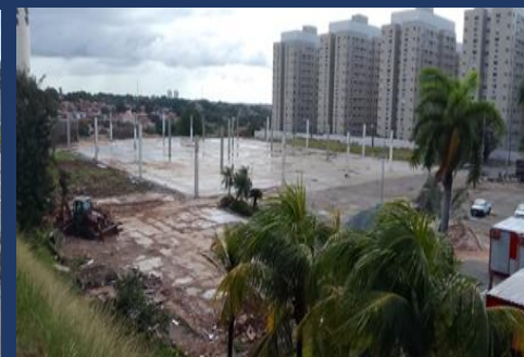
Conclusão Desmontagem da Cobertura Metálica
