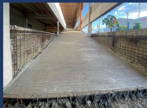
Concretagem Rampa Acesso ao Estacionamento
