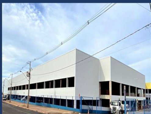
Fechamento Metálico da Fachada
