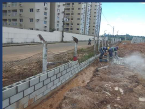
Execução do Muro de Divisa
