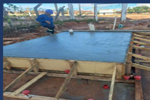
Execução da Base da Guarita
