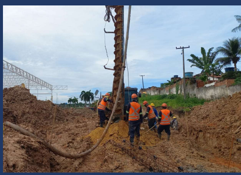
Execução de estacas
