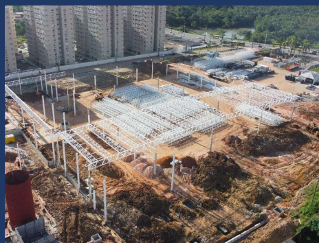
Visão aérea da obra
