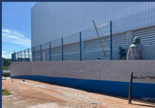
Instalação de Gradil
