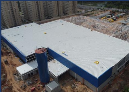
Visão aérea da obra
