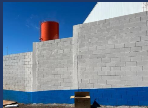
Pintura Muro - Externo
