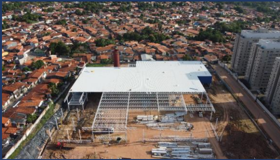
Visão aérea da obra
