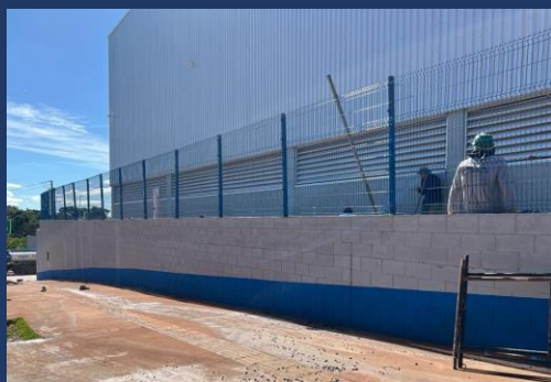
Instalação de Gradil
