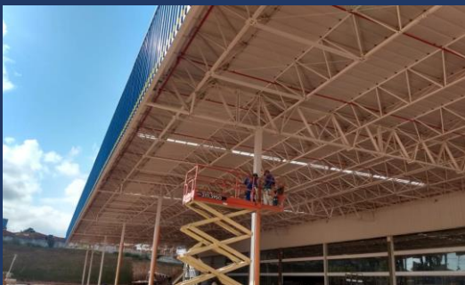
Execução da instalação da tubulação pluvial
