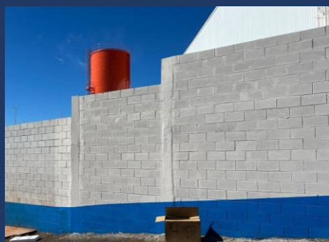
Pintura Muro - Externo
